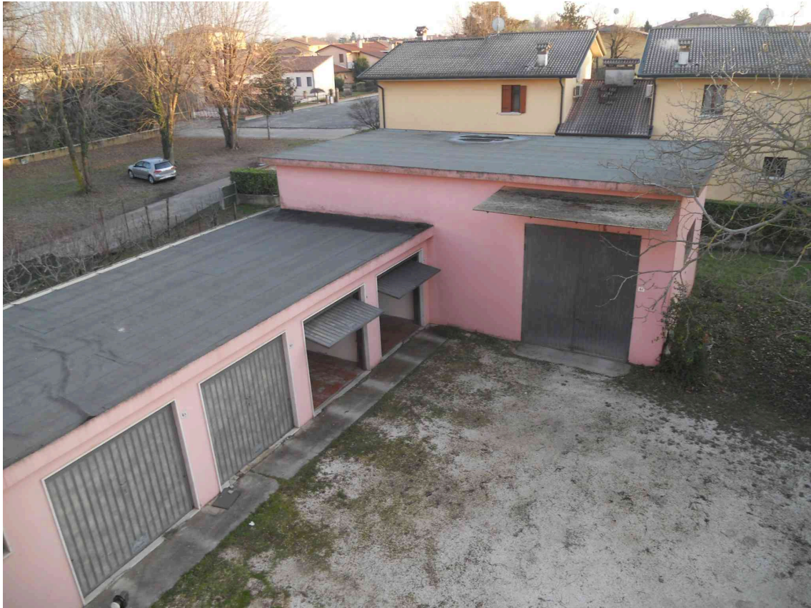
VISTA DALL'ALTO DEI GARAGES E DEL DEPOSITO SUB 15
