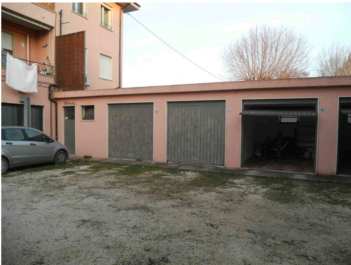
VISTA DEI 2 GARAGE SUB 4 E 5 E DELL'ACCESSORIO SUB 13
